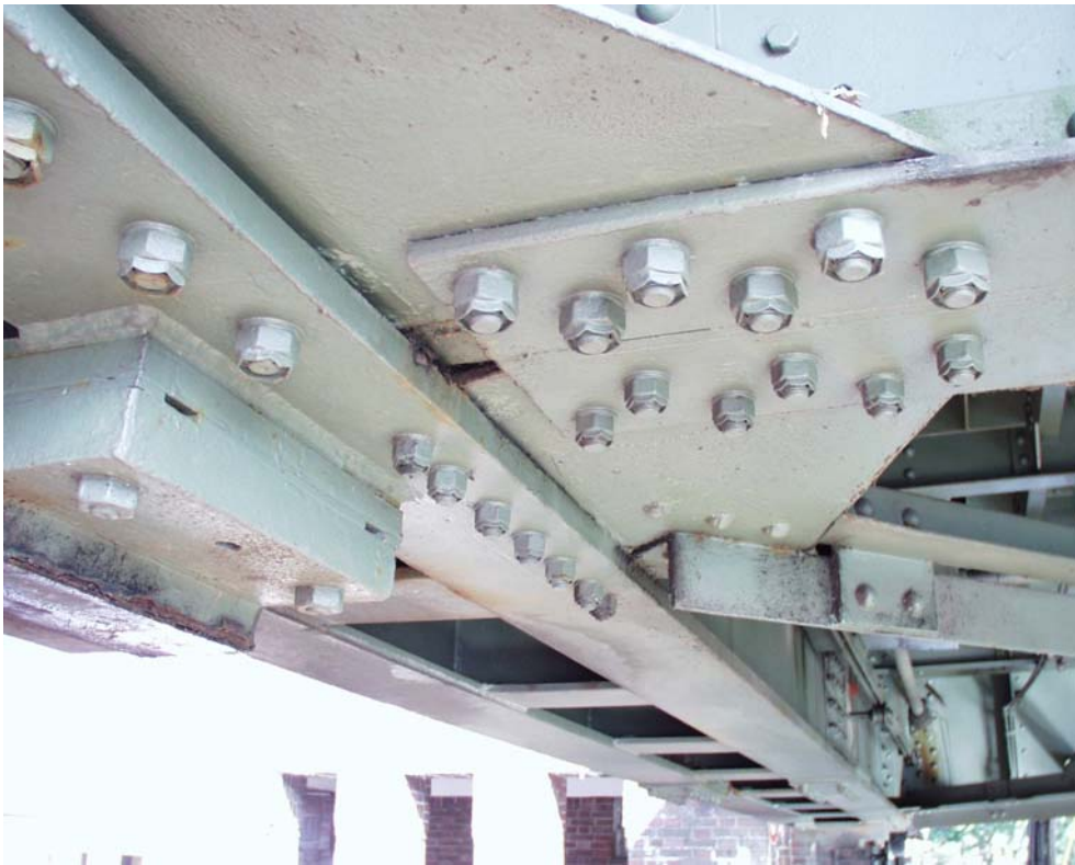
Bild 13 und 14: Beispiele Schraubanschlüsse EQT/Hauptträgeruntergurt
