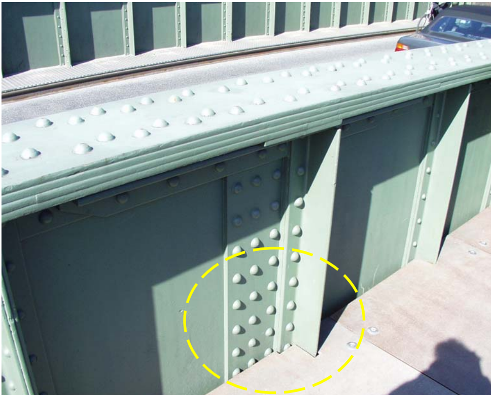
Bild 11: HT Ostseite mit Anschlussbereich Fußweg
