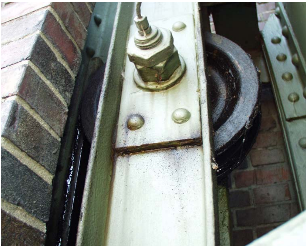
Bild 40 und 41: Querführungsrollen mit doppeltem Spurkranz
