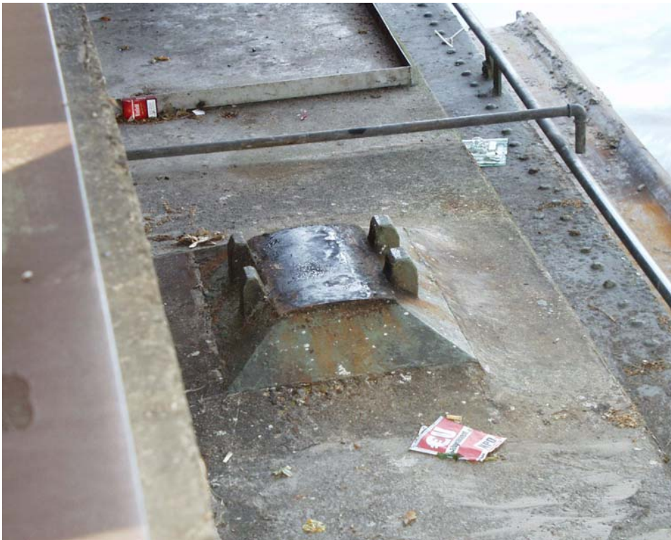
Bild 23 und 24: Festes Auflager Turm 4 (Bremer Str.) und zugehörige Lagerplatte am EQT
