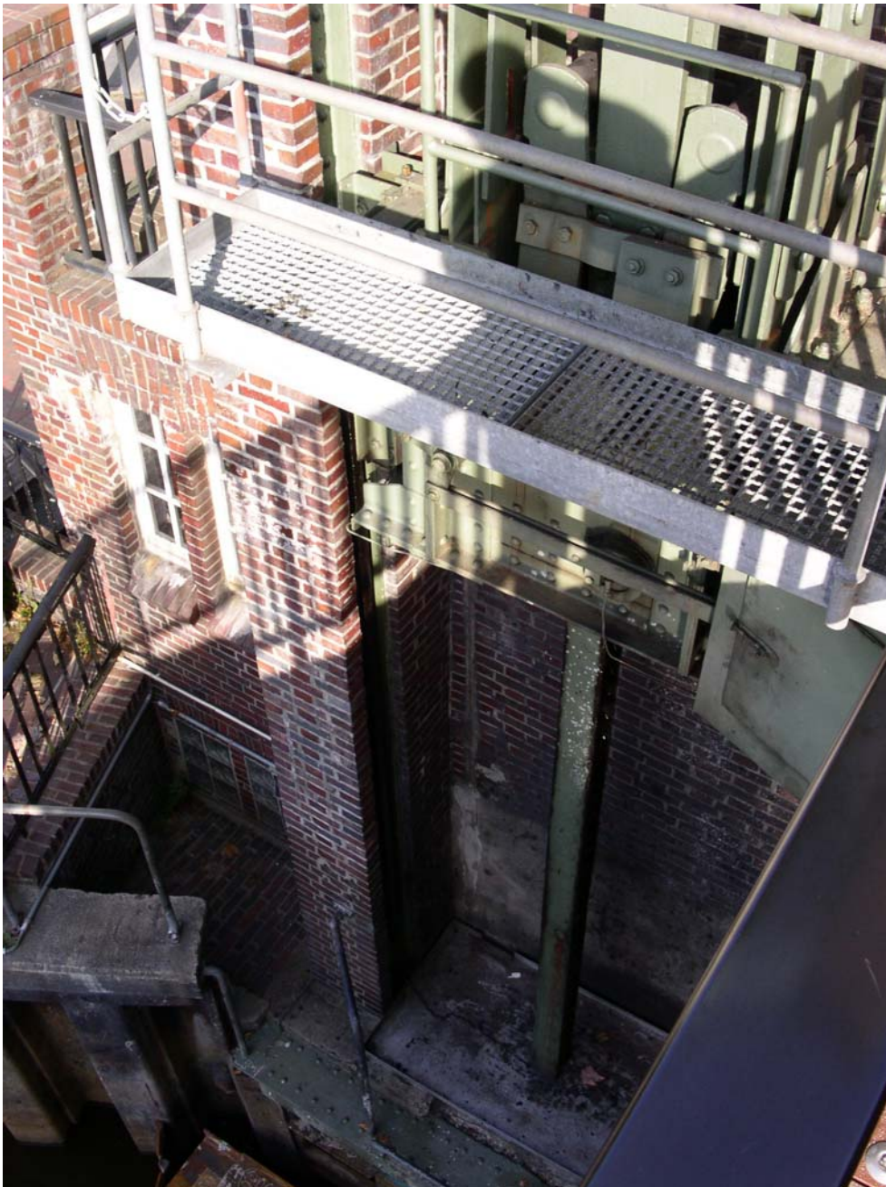
Bild 11: Mauerwerkskonsole zur Aufnahme der Horizontallasten aus der Brücke / Turm 2
