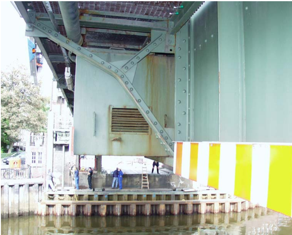
Bild 38 und 39: Spaltrostbildungen (Motorkasten / Hauptträger)
