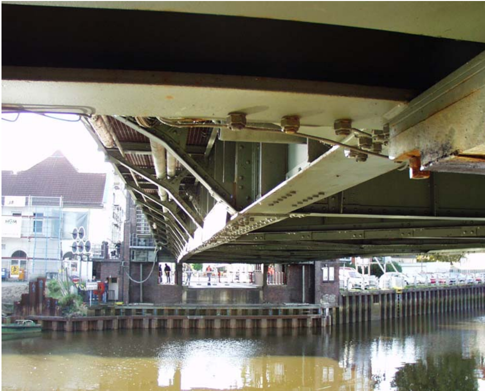
Bild 9: Heben der Brücke in die obere Position, Blick zum Damm
