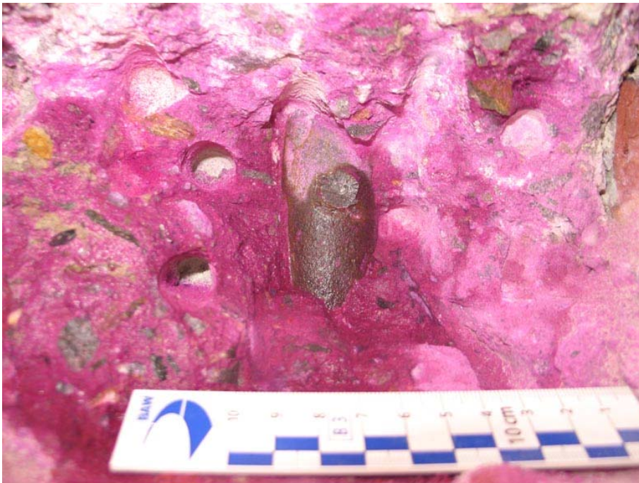
Bild 5: Erkundungsöffnung mit Indikatorlösung in Turm 4
