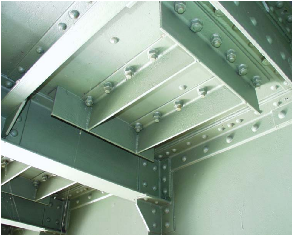
Bild 19 und 20: Details Fahrbahnverstärkungen / Querträger / Längsträger
