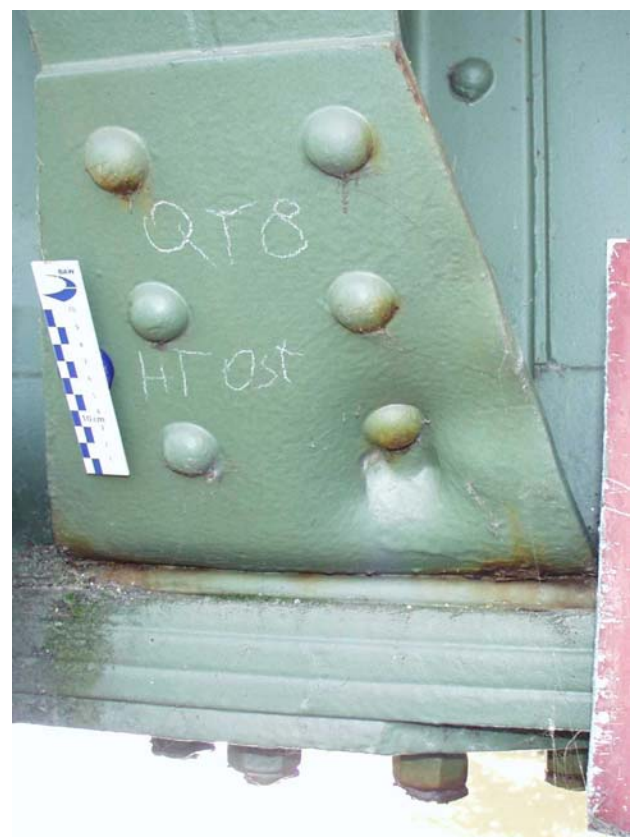
Bild 29, 30, 31: Beispiele für örtliche Kantenabrostungen und Verformungen an Blechen und Profilen
