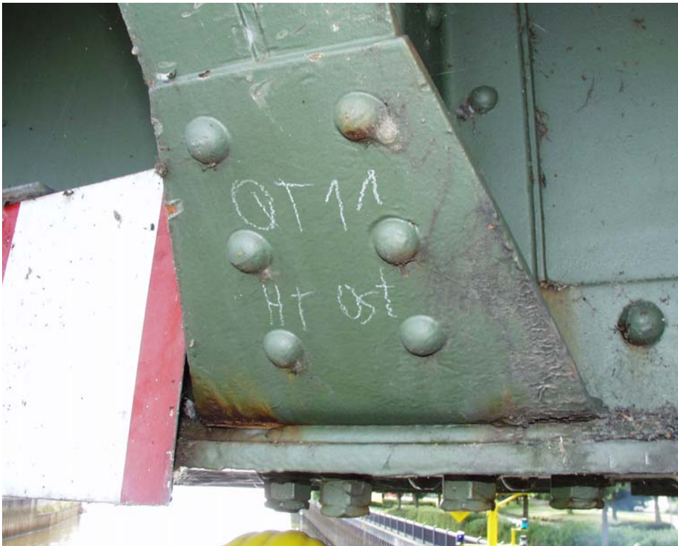
Bild 32 und 33: Beispiele für Spaltrostbildungen an den Anschlüssen Gehwegkonsolen / HT-UG
