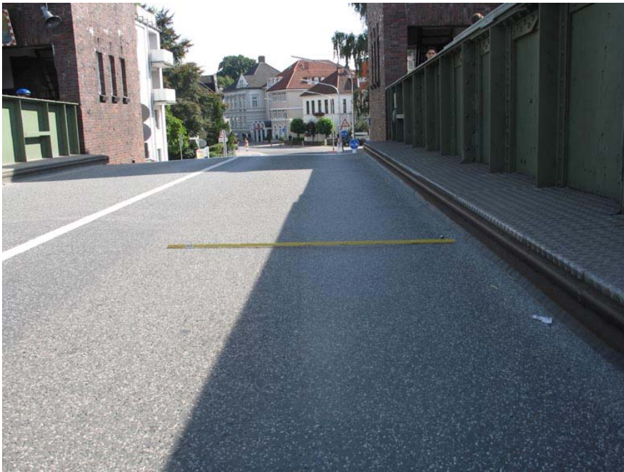
Bild 17: Spurrinne Fahrbahn
