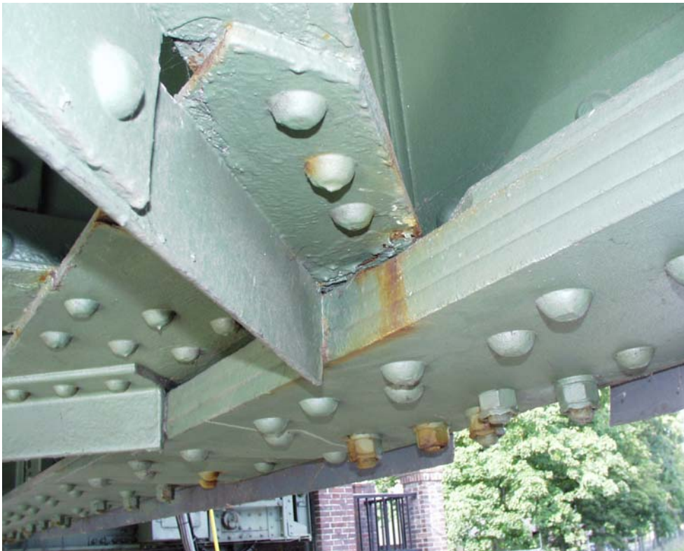
Bild 27 und 28: Beispiele für angerostete Schraubverbindungen
