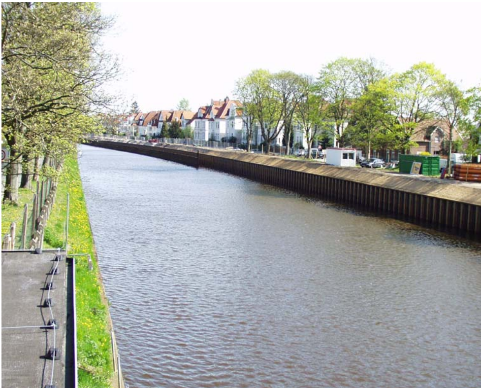
Bild 3: Küstenkanal östlich der Brücke
