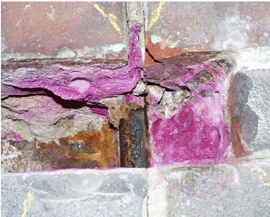
Bild 12: Erkundungsöffnung mit Indikatorlösung an Turm 2
