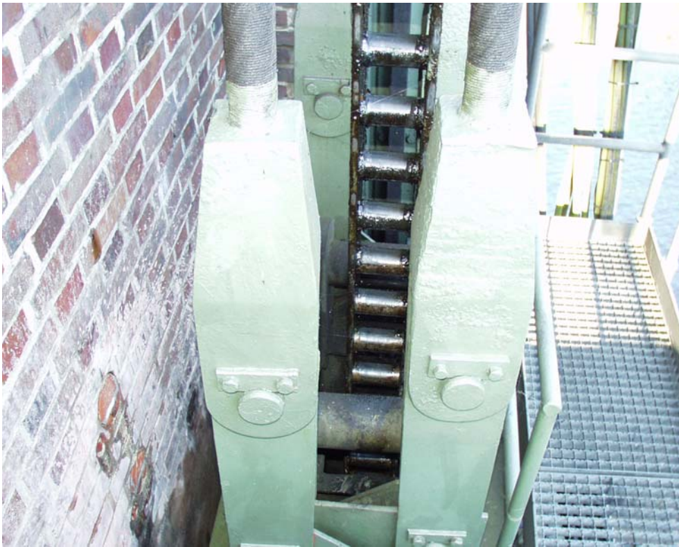
Bild 42 und 43: Triebstockleitern mit Abnutzungen
