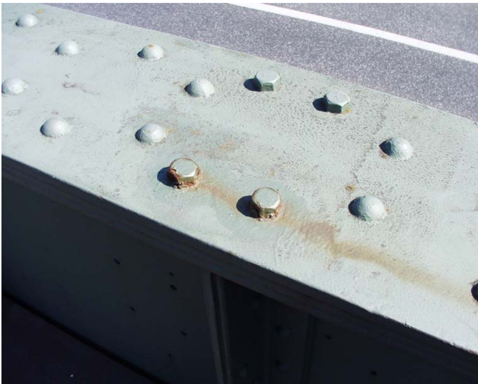
Bild 8: HT Westseite, Obergurt , Nietersatz durch Schrauben
