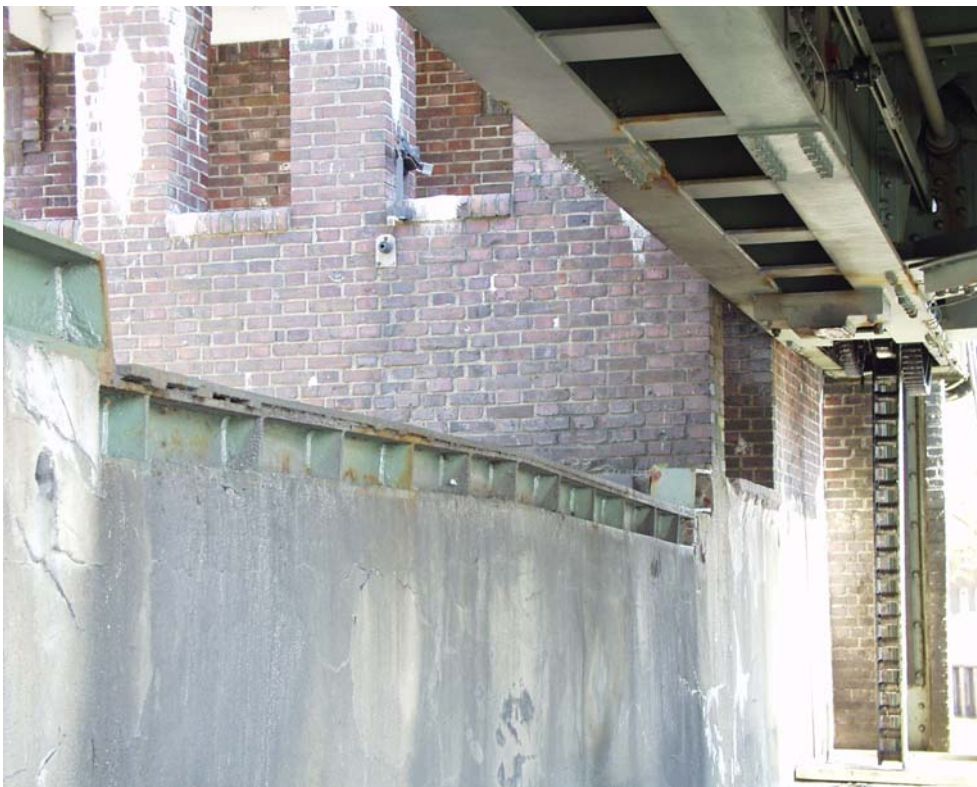
Bild 22: Brücke angehoben, Widerlager Dammseite, Untersicht EQT (Die ursprünglichen, stark abgerosteten Nietkonstruktionen beider Endquerträger wurden 1989 durch neue geschweißte Hohlkästen ersetzt, die an die verbleibende Fahrbahnkonstruktion über Schraubverbindungen angeschlossen wurden.)
