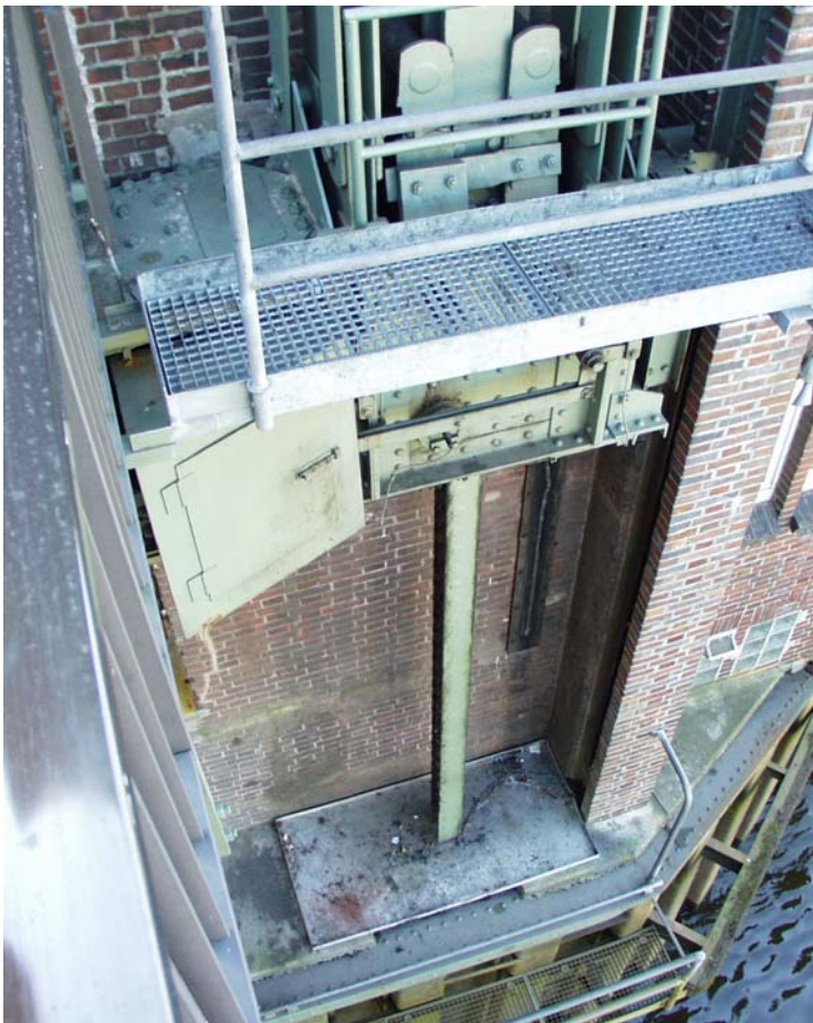
Bild 19: Kragarm Endquerträger (EQT), Brücke in angehobener und verriegelter Position
