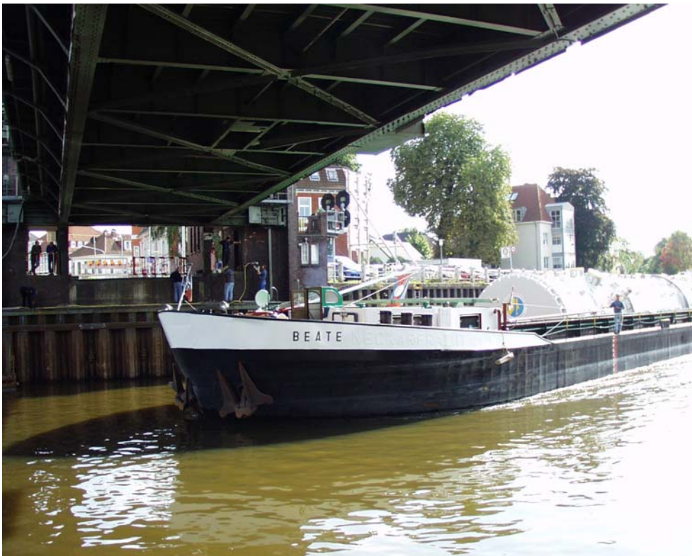
Bild 10: Brücke oben, Schiffspassage
