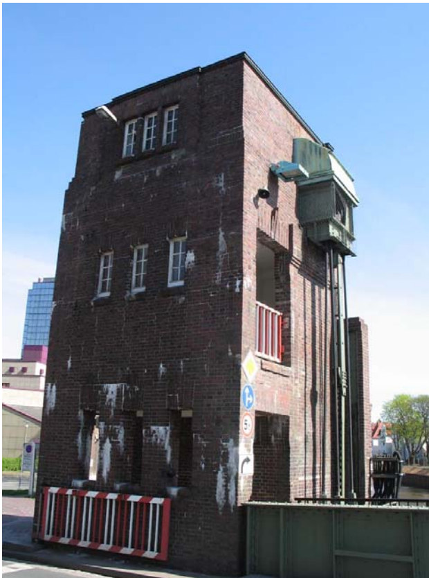
Bild 13: Aussinterungen an Turm 1
