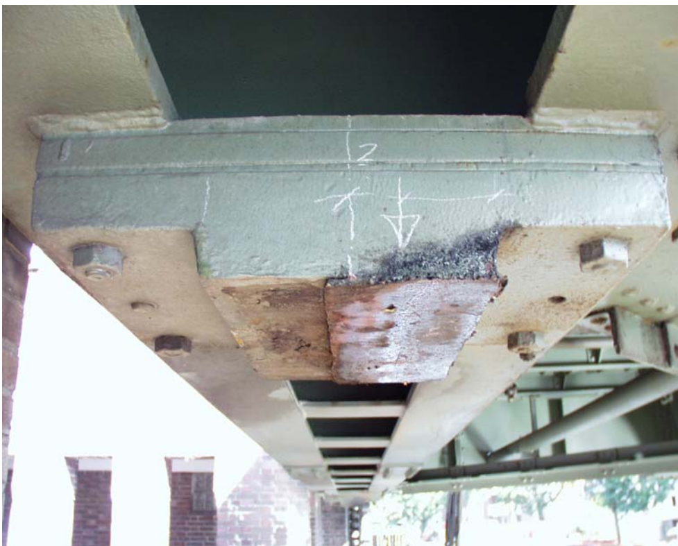
Bild 21 und 22: Bewegliches Auflager Turm 2 (Dammseite) und zugehörige Lagerplatte am EQT (Auflagerung mit Versatz zur EQT-Achse)
