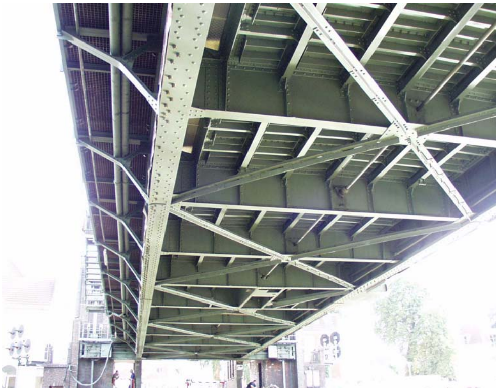
Bild 11: Untersicht mit Haupt-, Quer- und Längsträgern, Windverband, Gehwegkonsolen
