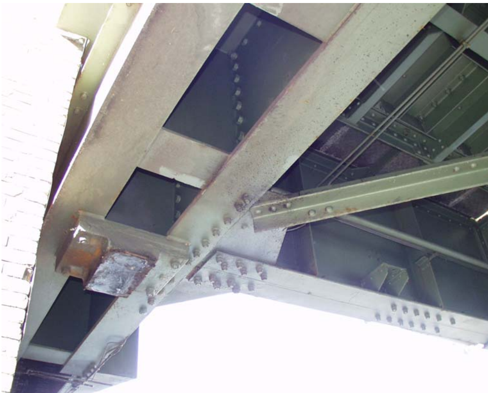
Bild 23 und 24: Festes Auflager Turm 4 (Bremer Str.) und zugehörige Lagerplatte am EQT
