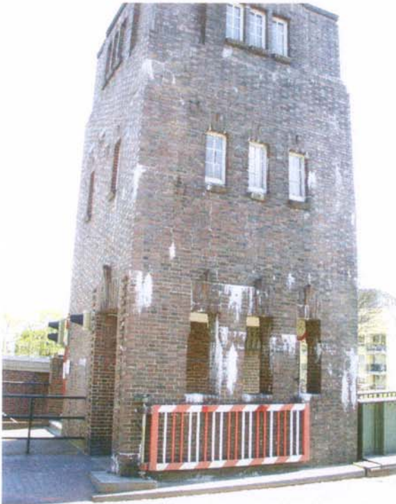
Bild 7 Aussinterungen
