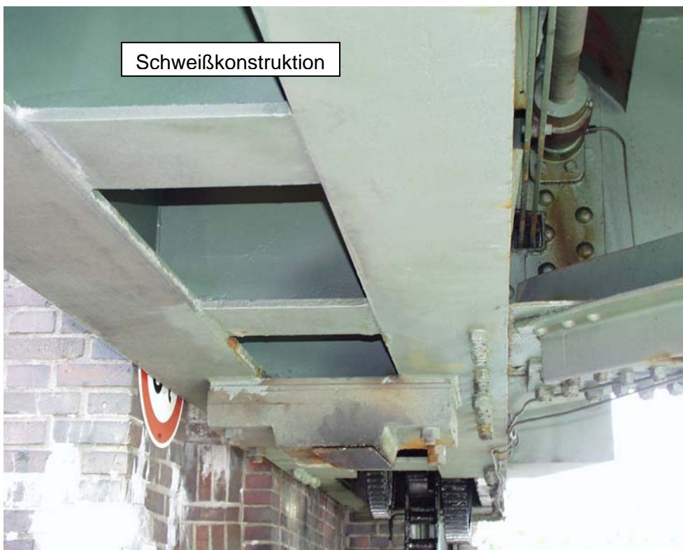
Bild 15 und 16: Endquerträger Nord (Spaltrost zw. UG und Knotenblech)
