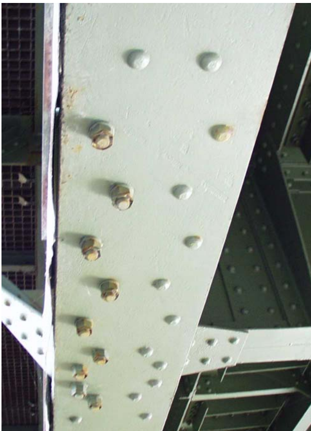
Bild 27 und 28: Beispiele für angerostete Schraubverbindungen
