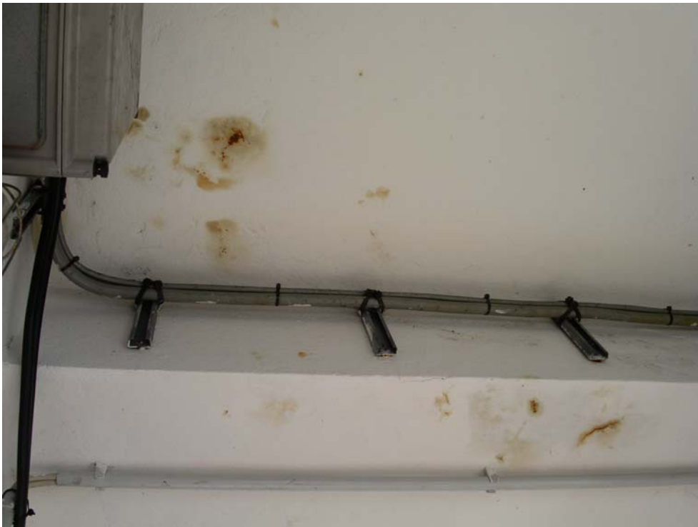
Bild 5: Rostflecken an der Treppenunterseite / Turm 1
