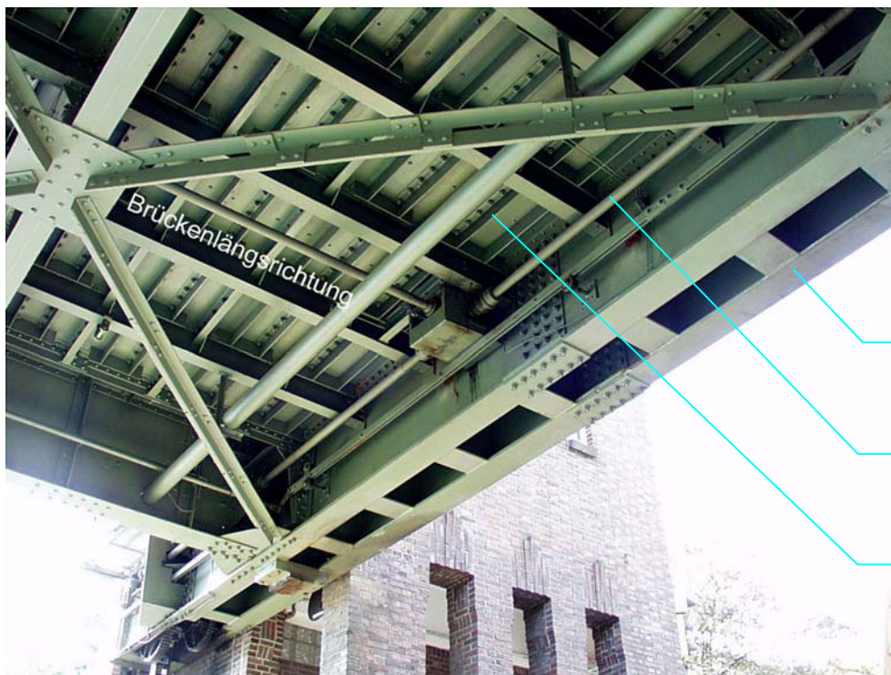
Bild 12: Untersicht mit Endquerträger (Dammseite)
