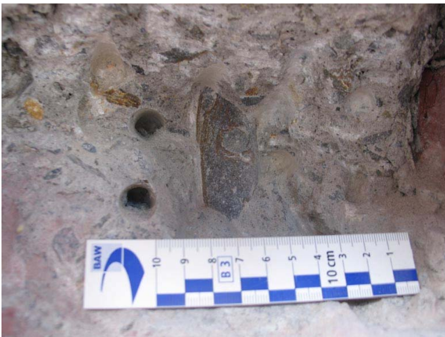
Bild 4: Detail Zugband in Erkundungsöffnung von Turm 4
