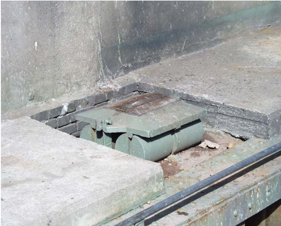
Bild 21 und 22: Bewegliches Auflager Turm 2 (Dammseite) und zugehörige Lagerplatte am EQT (Auflagerung mit Versatz zur EQT-Achse)
