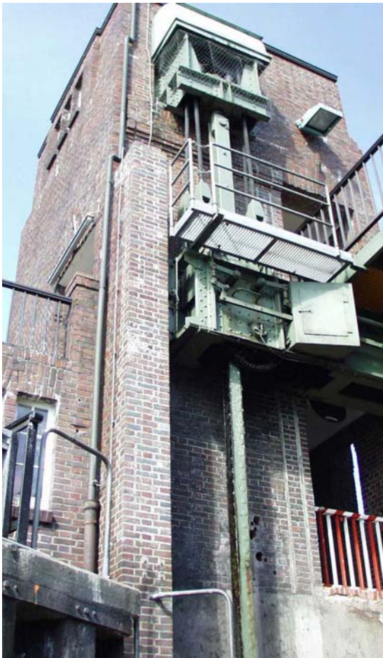
Bild 44, 45, 46, 47: Maschinentechnik in den Türmen und in den Kragarmen der Endquerträger (EQT)
