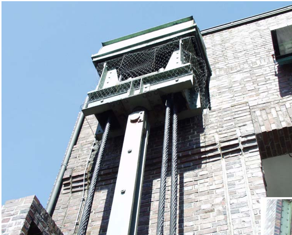
Bild 13: Seilführung und obere Triebstockanbindung am Turm
