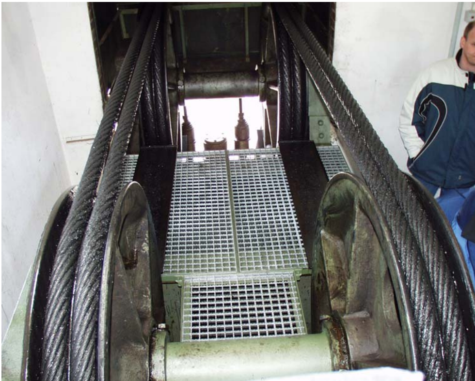
Bild 15 und 16: Seilscheiben der Gegengewichte in den Turmköpfen
