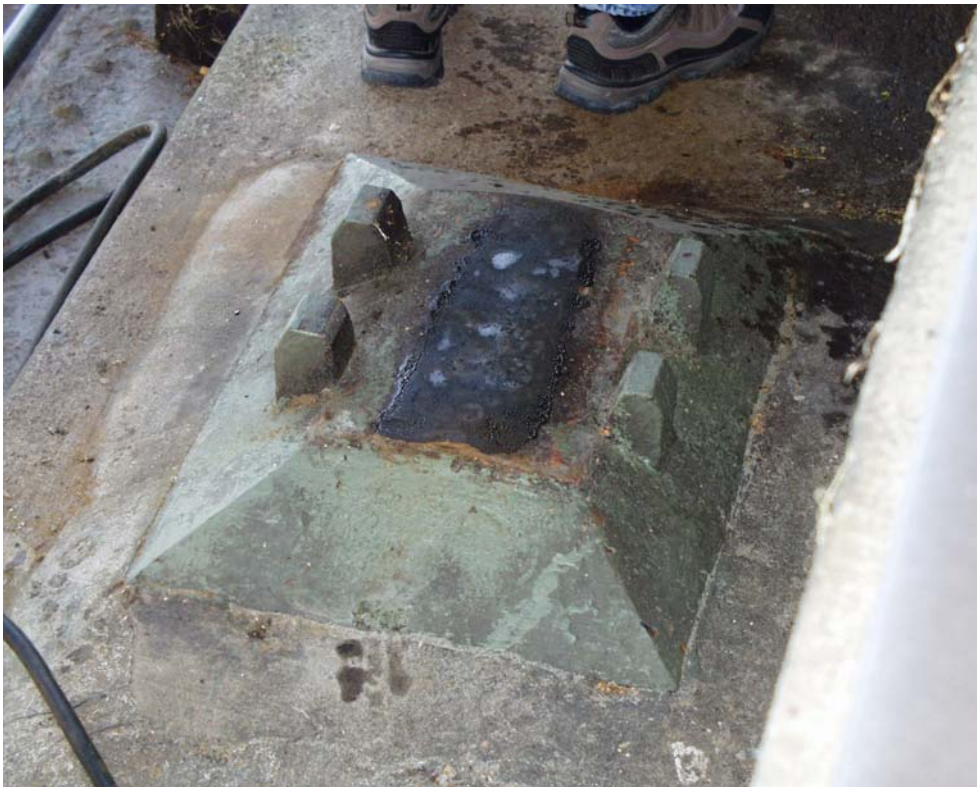
Bild 25 und 26: Festes Auflager Turm 3 (Bremer Str.) und zugehörige Lagerplatte am EQT
