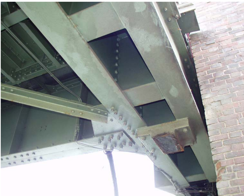
Bild 25 und 26: Festes Auflager Turm 3 (Bremer Str.) und zugehörige Lagerplatte am EQT
