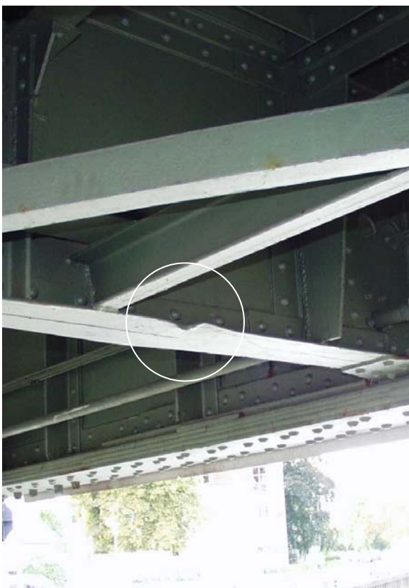
Bild 29, 30, 31: Beispiele für örtliche Kantenabrostungen und Verformungen an Blechen und Profilen
