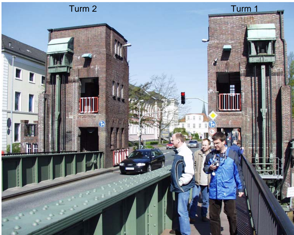
Bild 2: Brückentürme auf der Damm-Seite
