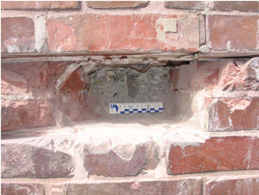
Bild 3: Zugband in Erkundungsöffnung von Turm 4
