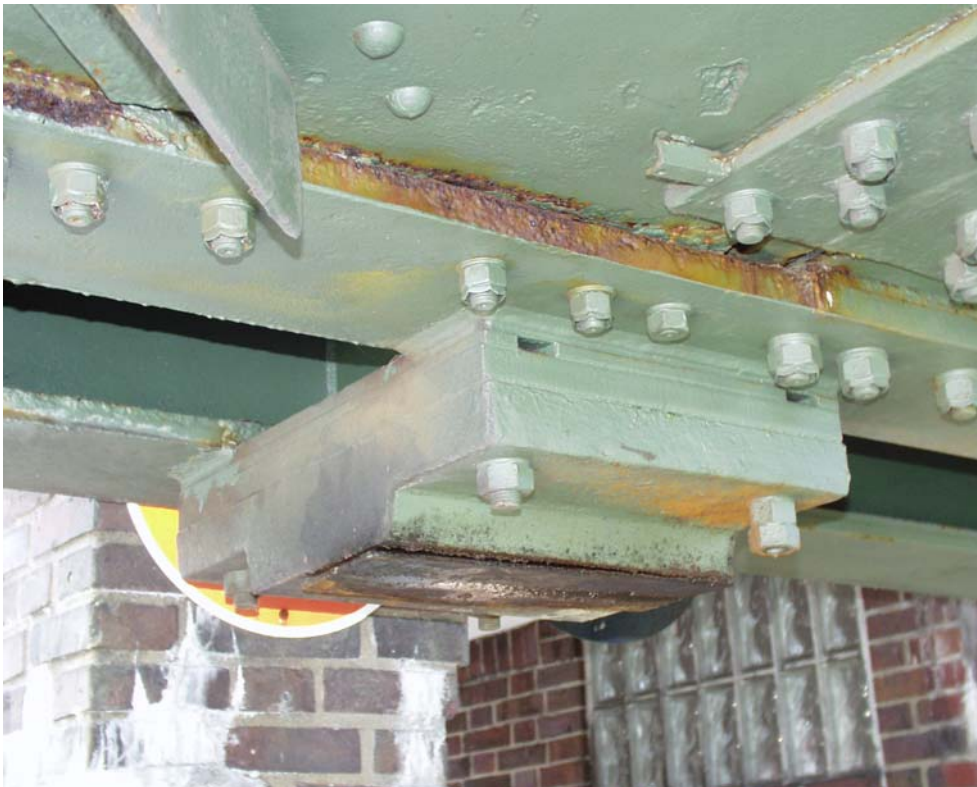
Bild 15 und 16: Endquerträger Nord (Spaltrost zw. UG und Knotenblech)
