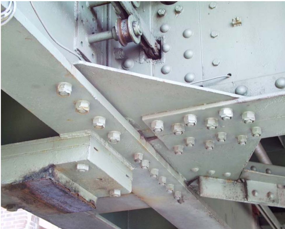
Bild 25: Brückenlagerung EQT Nordseite (Oberteil des bewegl. Lagers und Schraubanschlüsse der neuen EQT)
