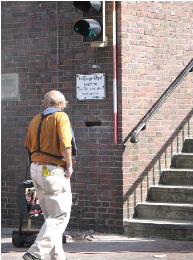
Bild 9: Turm 2 am Treppenaufgang mit Erkundungsöffnung
