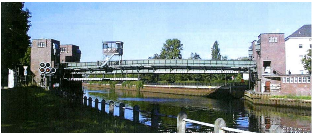
Abbildung 2: Cäcilienbrücke im Juni 2003 (Ansicht von Osten, Foto: WSA Bremen)
