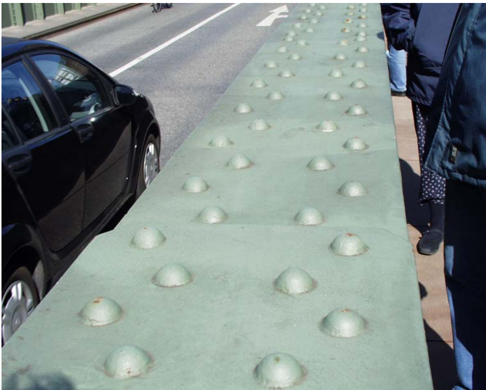
Bild 10: HT Ostseite, Obergurt mit genieteten Lamellenpaketen
