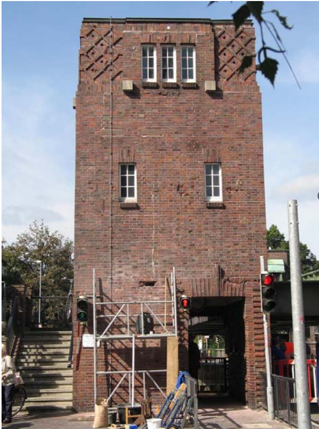
Bild 1: Turm 4 mit Erkundungsöffnung
