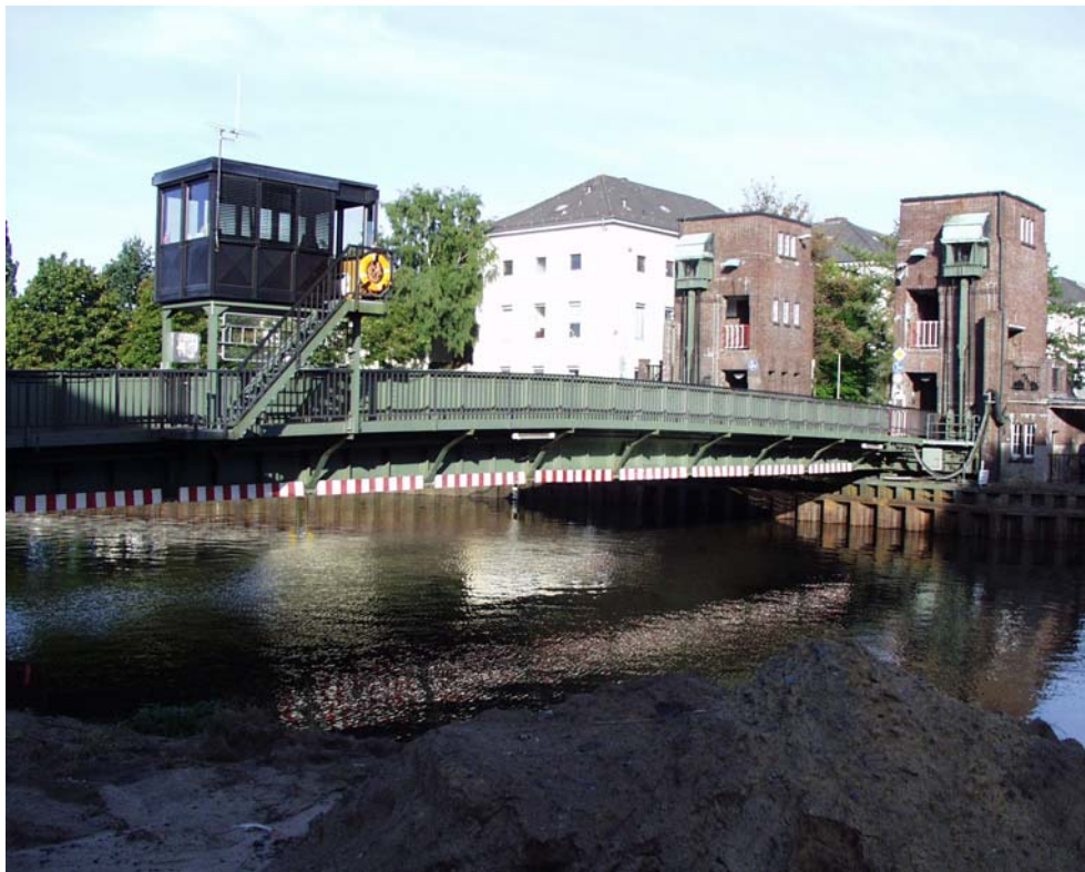
Bild 1: Brücke mit Blick zum Turm 1 und 2 (Nordseite, Damm)
