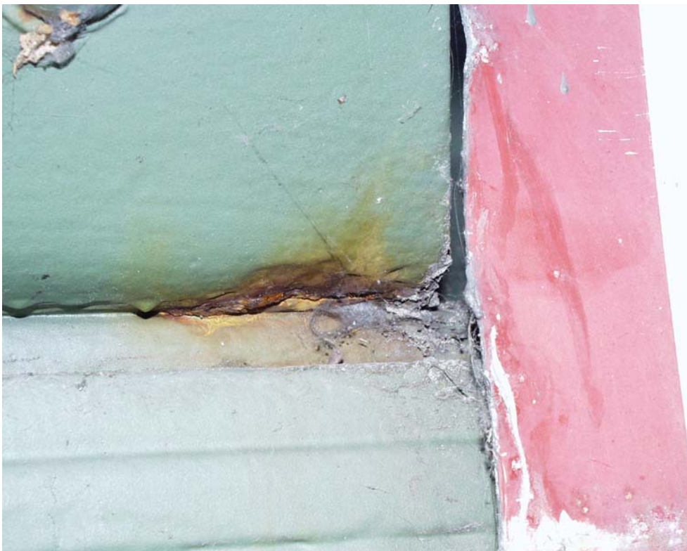
Bild 32 und 33: Beispiele für Spaltrostbildungen an den Anschlüssen Gehwegkonsolen / HT-UG
