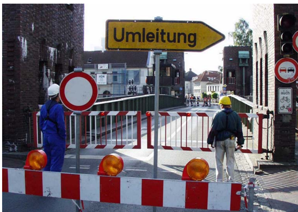
Bild 2: Sperrung der Brücke für Fahrzeugverkehr ab ca. 9:30 h
