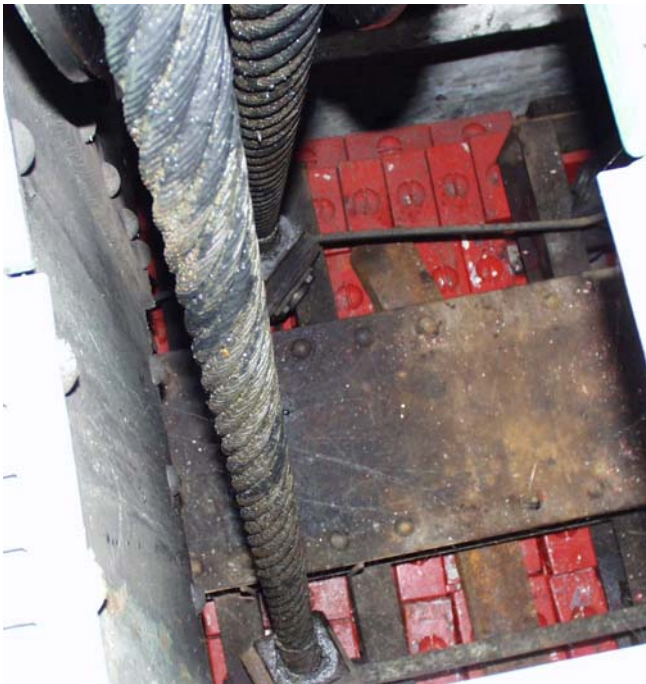
Bild 17 und 18: Seilbefestigung an den Gegengewichten
