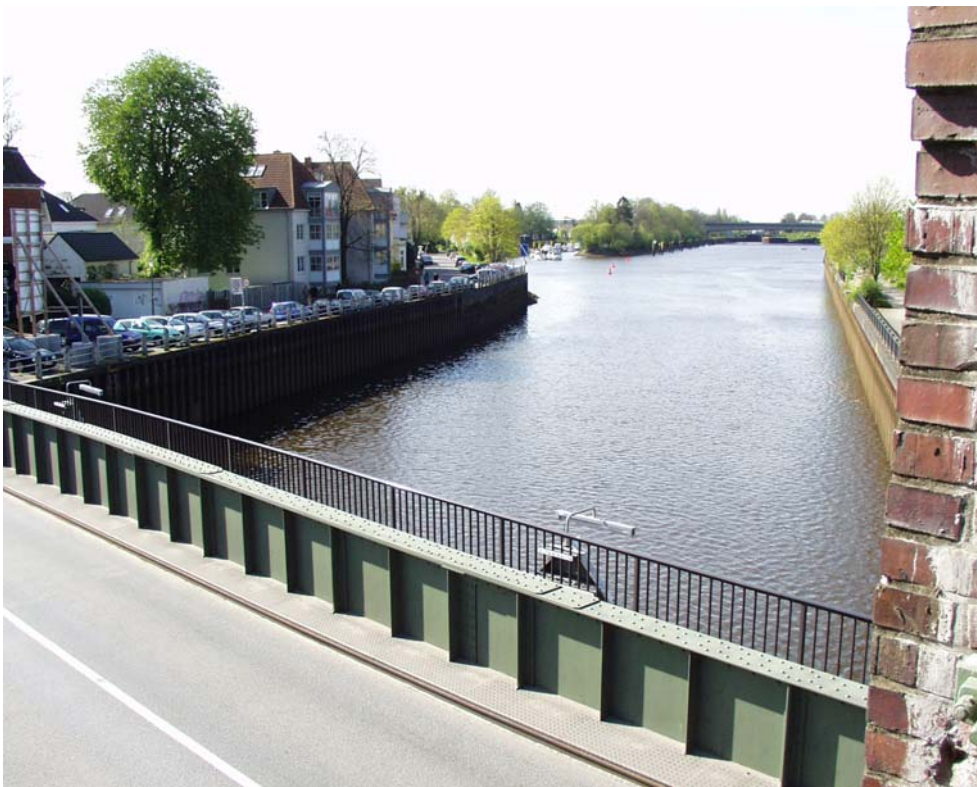
Bild 4 Küstenkanal westlich der Brücke
