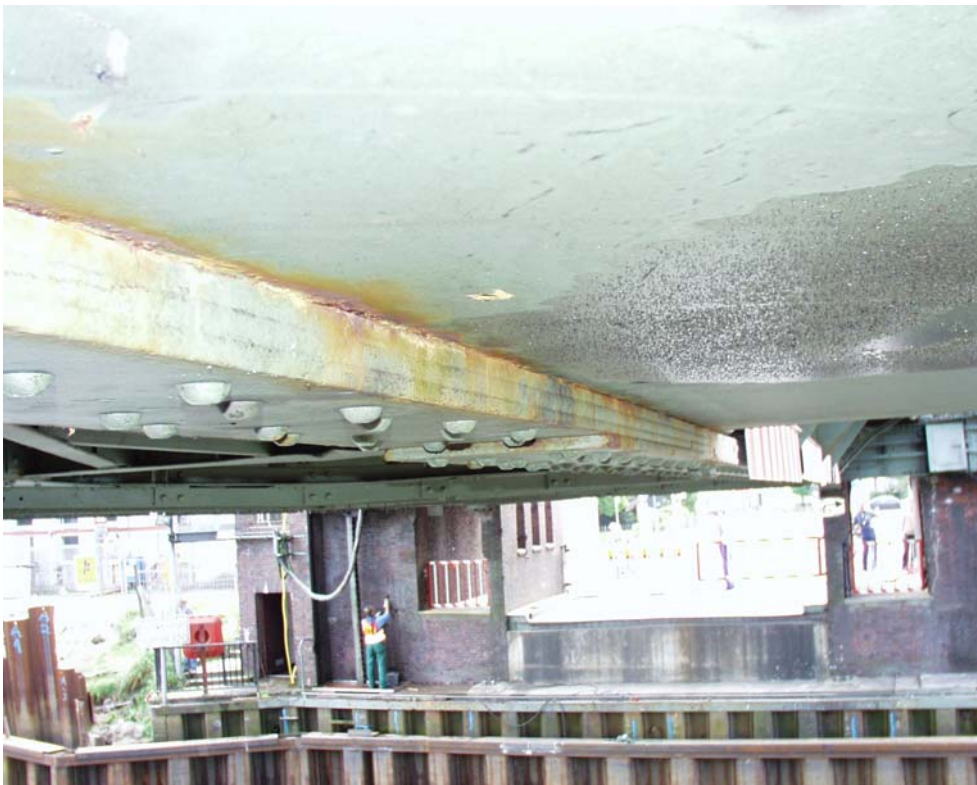
Bild 38 und 39: Spaltrostbildungen (Motorkasten / Hauptträger)
