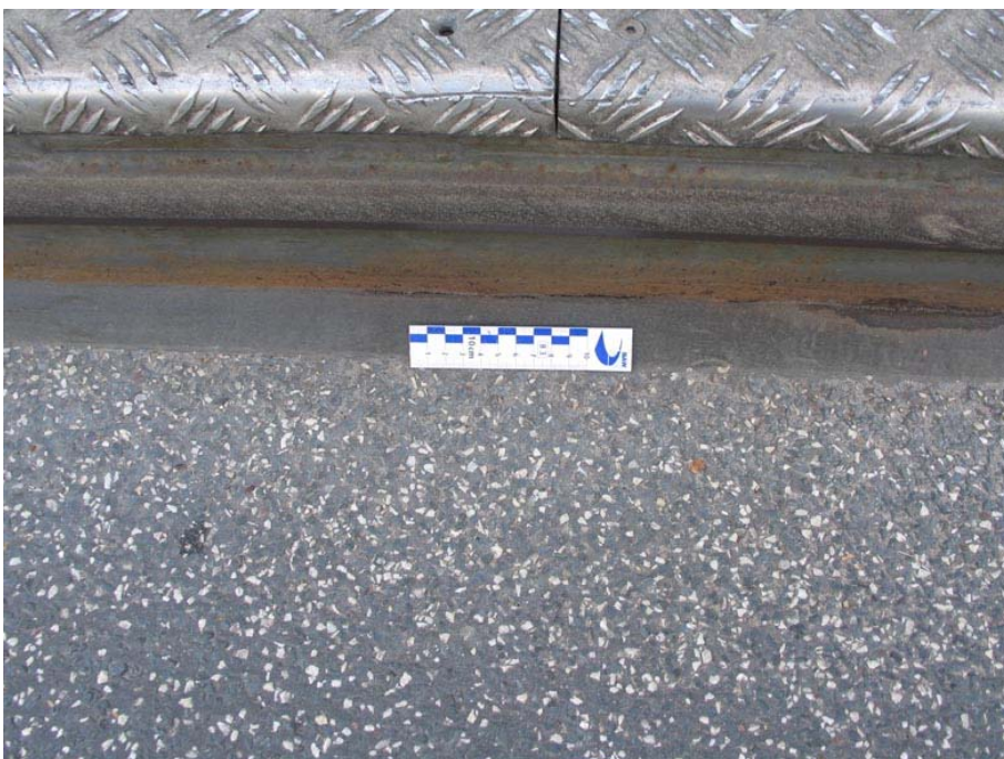
Bild 20: Schadhafter Fahrbahnanschluss
