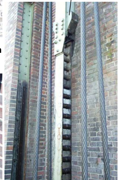
Bild 13: Seilführung und obere Triebstockanbindung am Turm
