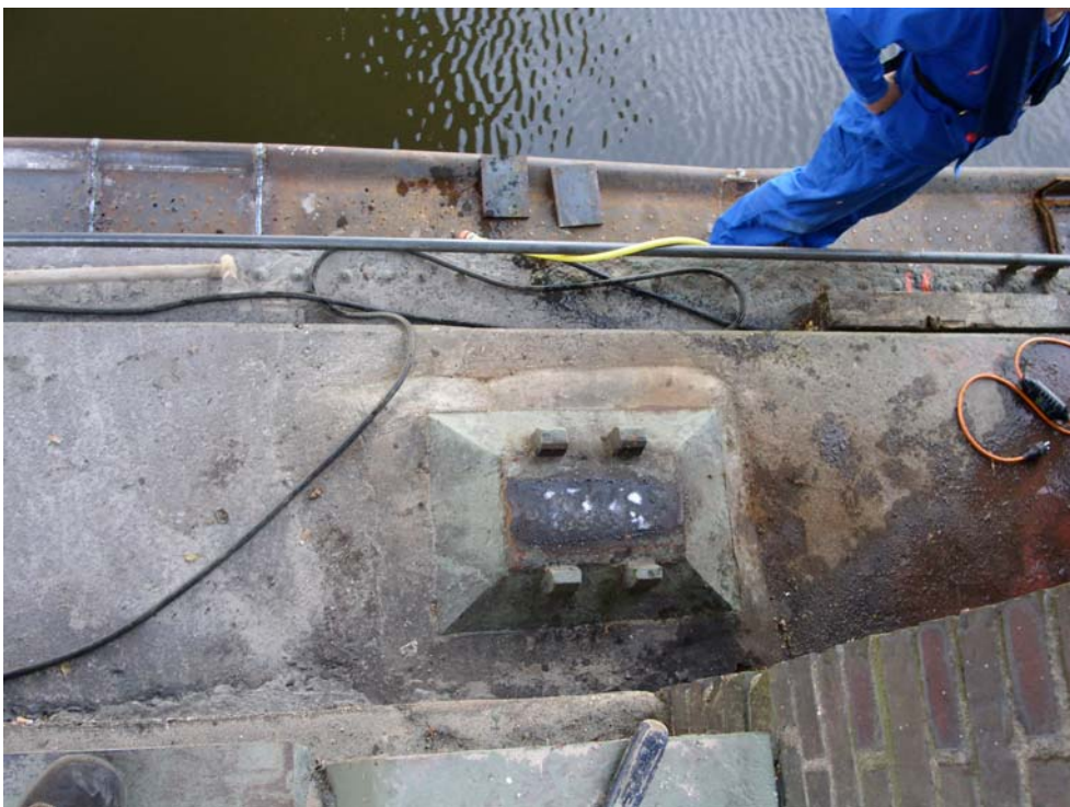
Bild 13: Brückenaufleger ohne sichtbare Schäden der Betonkonstruktion / Turm 3
