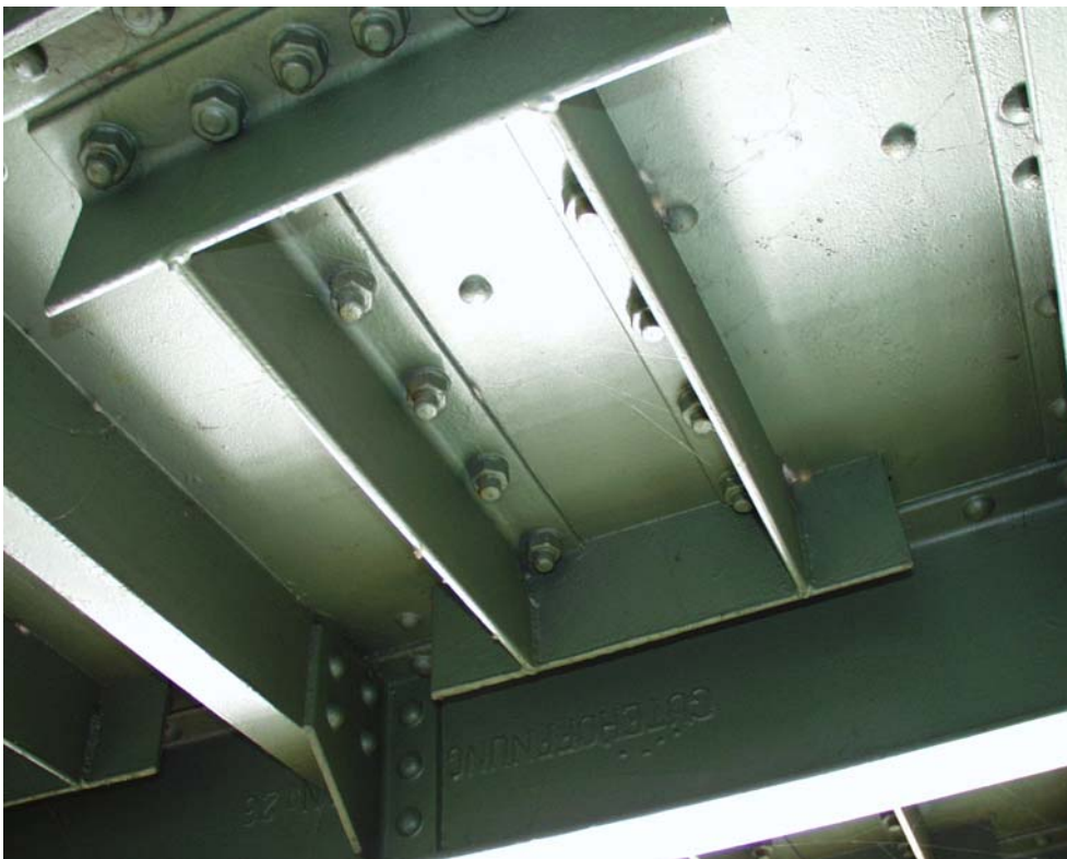
Bild 19 und 20: Details Fahrbahnverstärkungen / Querträger / Längsträger
