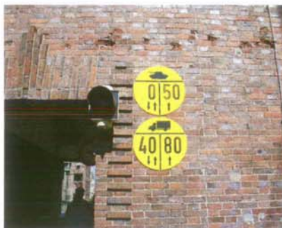
Bild 6 abgeplatzte Ziegel
