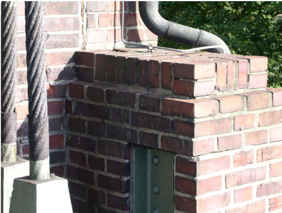
Bild 7: Mauerwerkskonsole zur Aufnahme der Horizontallasten aus der Brücke/Turm 1
