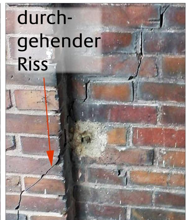
Außerplanmäßige Belastungen und Zwangskräfte durch Sprengwirkung im Mauerwerk infolge von Korrosion der eingemauerten Stahlprofile und durch die Abstandsverringering der Hubtürme, die zu einem Verklemmen des Überbaus führen.
