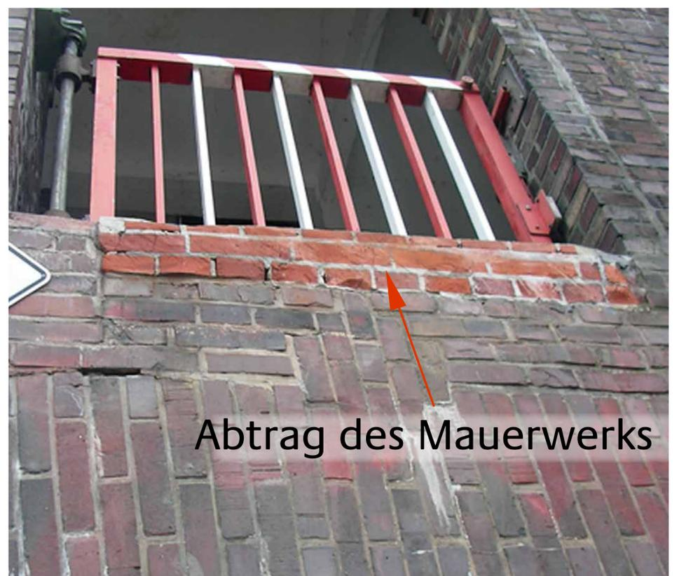
Abstandsverringern führt zu Verklemmungen des Überbaus und zusätzlicher Belastung der Antriebe. Keine weiteren Möglichkeiten des Materialabtrags ohne Eingriffe in tragende Teile. Dringender Handlungsbedarf, um den sicheren Betrieb und die Funktion des Bauwerks aufrecht zu halten.
