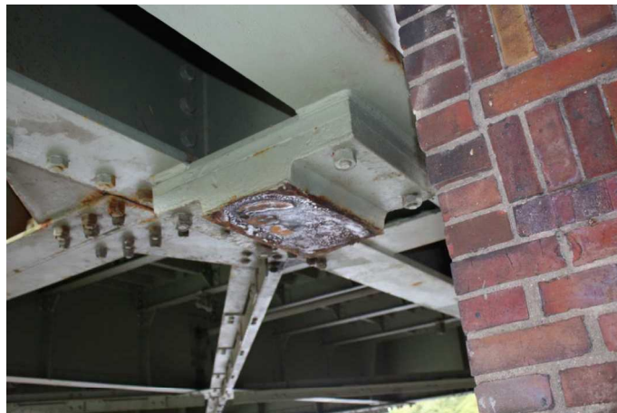
34 Auflager Hubbrücke IMG_1413.JPG
