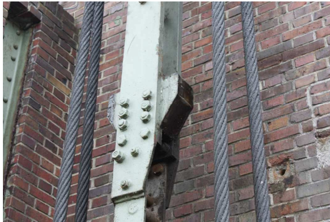
10 Haltetaschen Verriegelung am Triebstock IMG_1352.JPG
