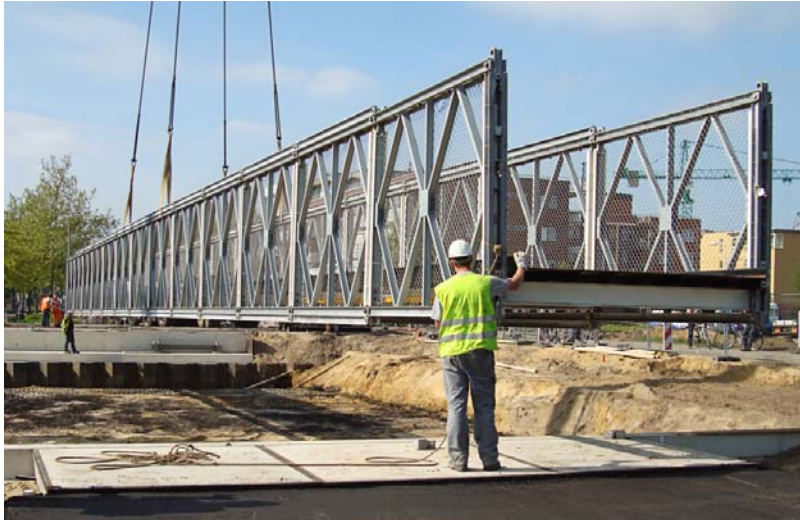
Bild 6-2 Beispiel Behelfsbrücke Montage
