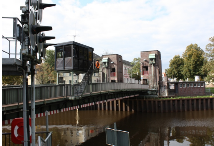
Bild 1-1 Übersicht Brücke geschlossen
