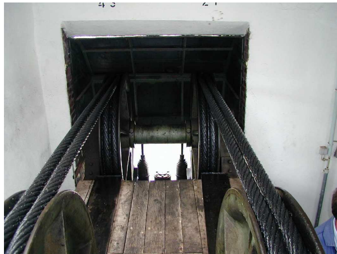
21 P6150574 Umlenkrollen, Turm 4.jpg
