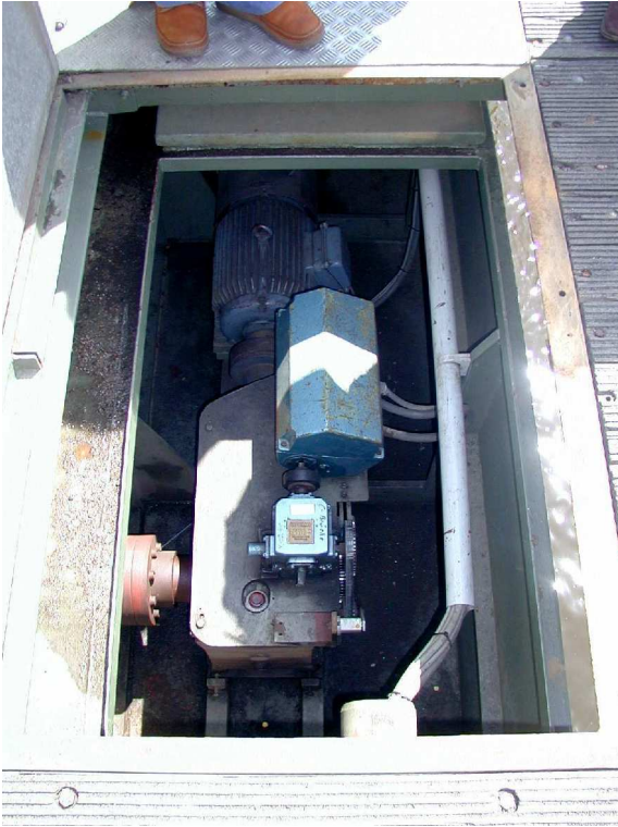
01 P6150575 Antriebsmotor+Getriebe-Endschalter.jpg
