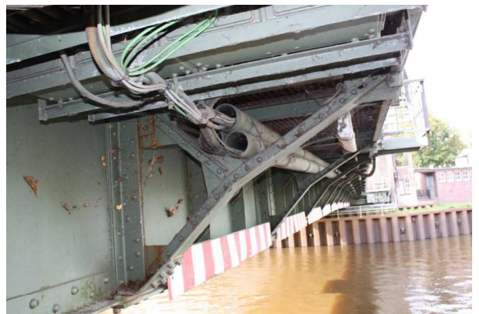
53 Leitungen unterhalb der Brücke IMG_1393.JPG
