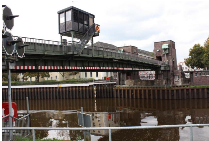
Bild 1-2 Übersicht Brücke geöffnet
