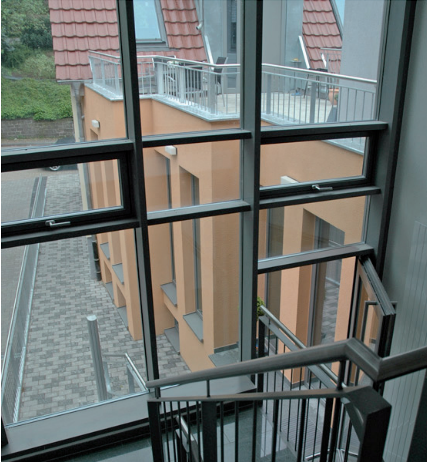
Referenz Pfosten-Riegel-Fassade: nach innen öffnende Fensterelemente (Abbildungen nur für den nicht-öffentlichen Gebrauch!)
