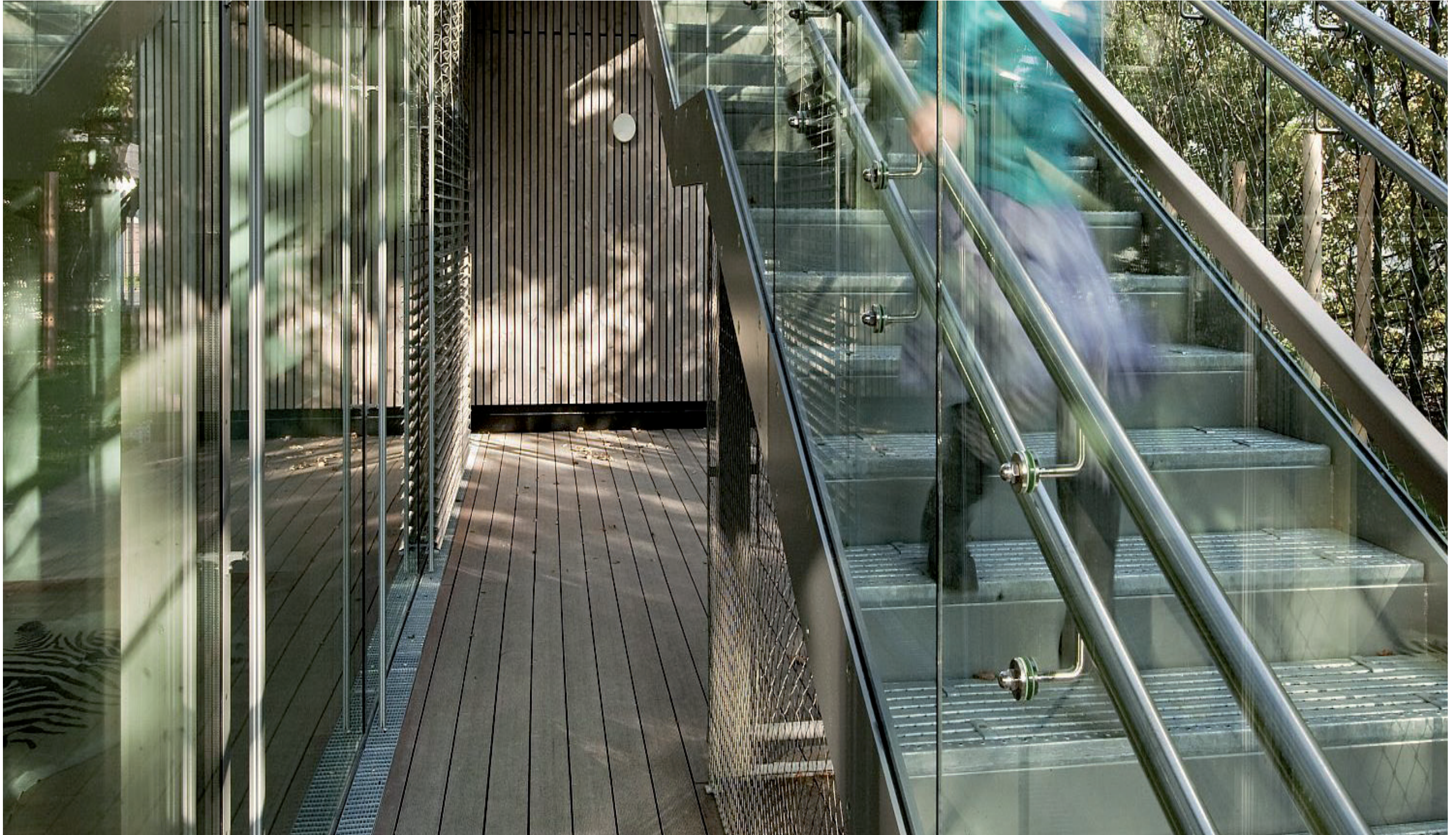
Geschlossene Setzstufen / Referenz 2 Stahltreppe (Clemens Kirsch)
