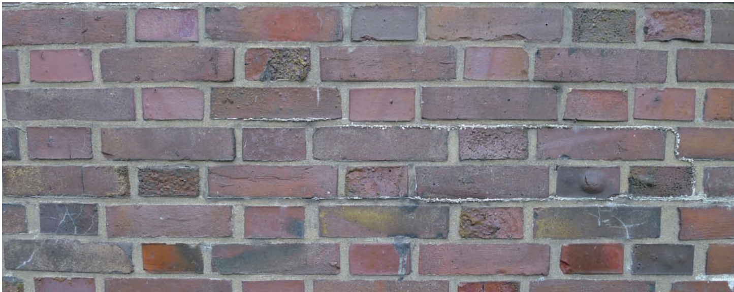
Referenz Verblendstein: Bestand, blaubunt, zementgraue Fuge, flämischer Verband
