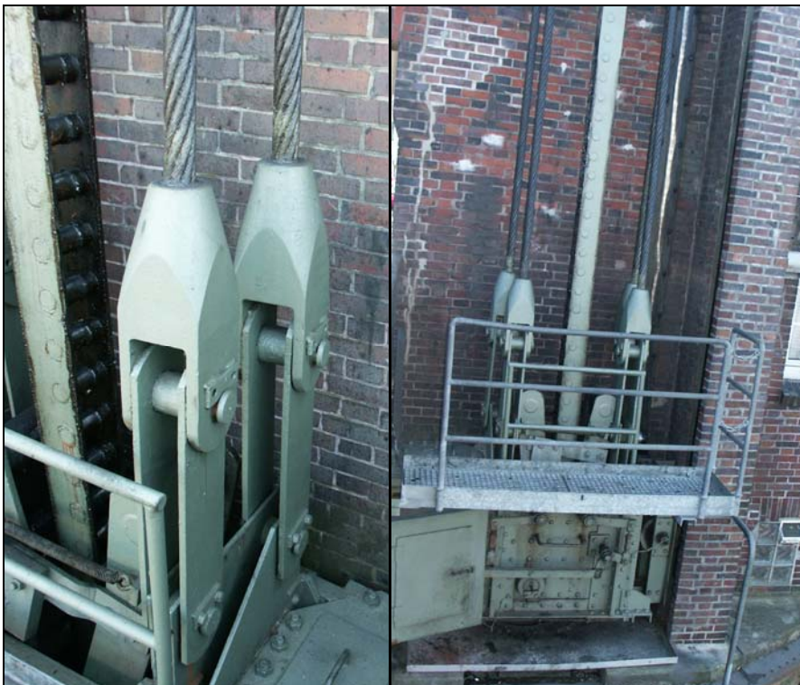
Abb. 3-7: Triebstock mit Tragseilen und Getriebe G5
