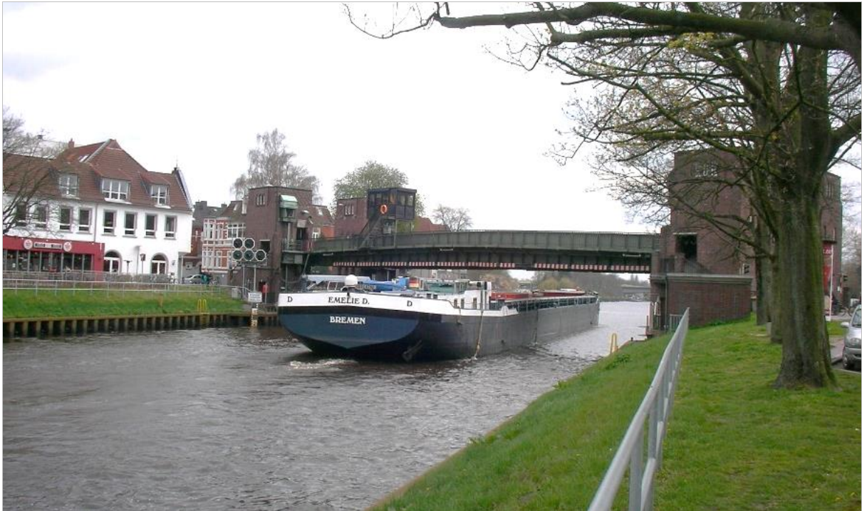
Abbildung 1: Cäcilienbrücke in Hochlage (Quelle: WSA WJN, 2014)
